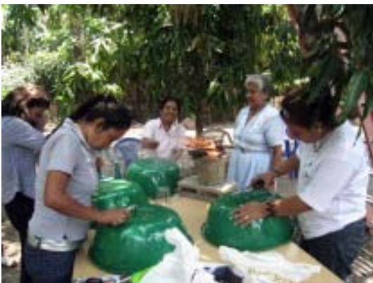
Gemeinsam werden die ersten Biofilter gebaut..
